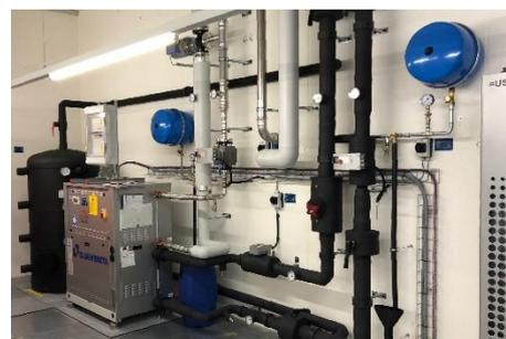
**2021** Auf engstem Raum mit 1'000 Mannstunden für die reversiblen Wärmepumpenanlage mit Abwärmenutzung für das neue Betriebsgebäude Duttweilerbrücke der SBB.
