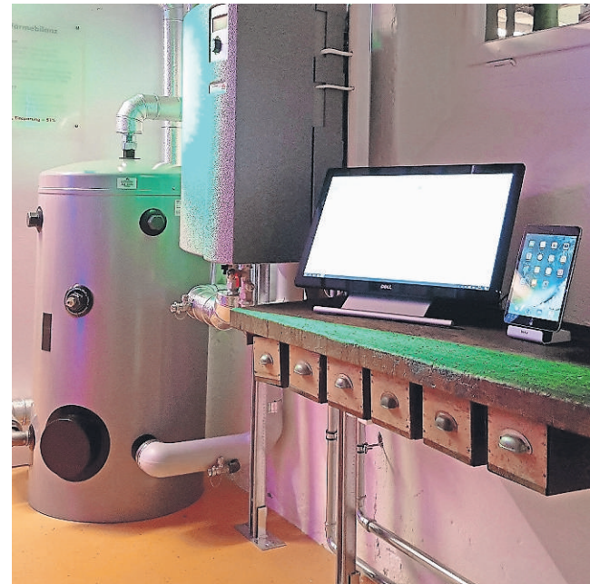
Wärmepumpe mit natürlichem Kältemittel, rechts die alte Werkbank aus dem Jahr 1947.
